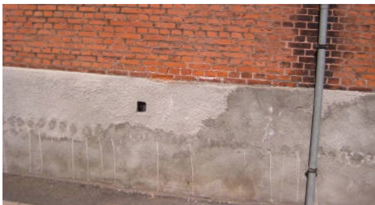
Der er udført injicering på Korsikavej
