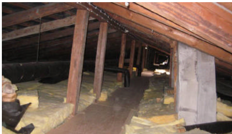
Sadelspær der hviler af på facader og på stolper.
