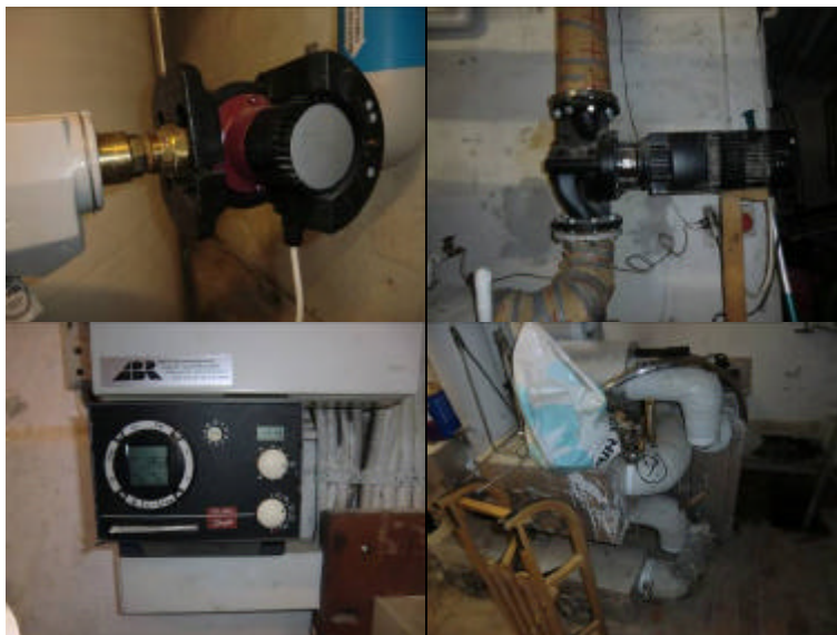
Varmecentralen er tidssvarende og i god stand.
