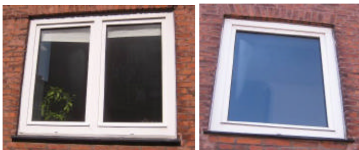
Eksempel på vinduer
